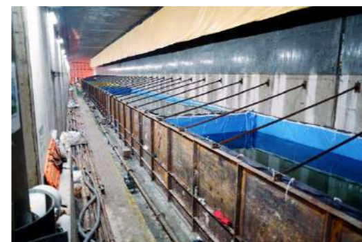
I bacini di Tuzla, dove sono stati costruiti gli 11 segmenti del tunnel, poi trasportati via mare (foto a destra) fino al Bosforo. Sotto, a sinistra, le vasche piene d'acqua che zavorravano i segmenti per calarli sul fondale; a destra, il pontile con cammino d'accesso al segmento poggiato sulla sponda asiatica.
