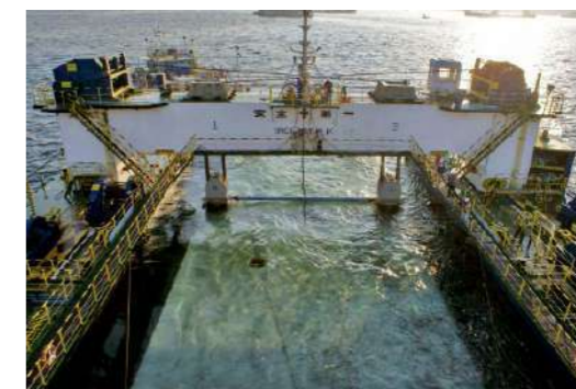
Le principali fasi di costruzione del tunnel. A sinistra, lo scavo della trincea da una chiatta, e qui a lato il maxi livellatore robotizzato che l'ha spianata dopo i lavori di scavo e consolidamento del fondale marino.
